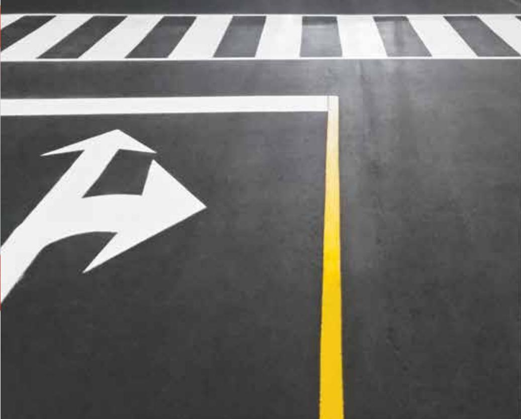
این محصول بر پایه رزین اکریلیک ترمومپلاستیک بوده و جهت خط کشی طولی خیابانی با ماشین خط کشی مخصوص قابل اجرا می باشد. با توجه به زمان خشک شدن سریع، این رنگ را می توان بدون نیاز به مسدود نمودن جاده برای زمان طولانی، اعمال نمود. این رنگ در برابر سایش، خراش و شرایط آب و هوایی نامناسب مقاومت بسیار مناسبی دارد.
